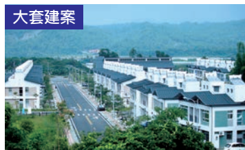
高雄 / 小林村 2011年安裝，使用15年， NSK-45×120台
