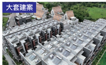
台中 / 餘慶開元 2024年安裝，使用2年， TOP-348×47台
